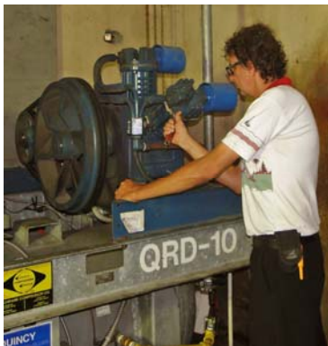
Reparaties aan de Compressor voor de zuurstof machine.
