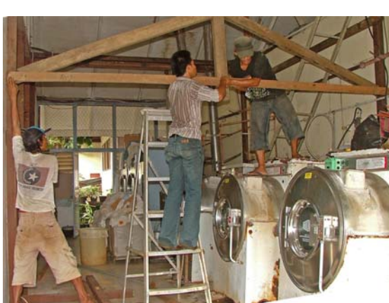
Op de foto zijn we bezig met wat houtwerk om de water toevoer naar de wasmachines te verbeteren.
